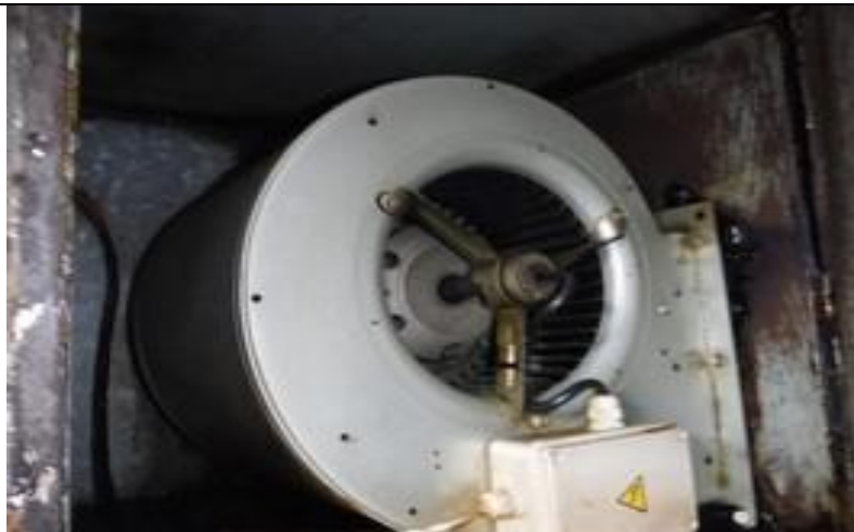
6. Fan Unit Before
