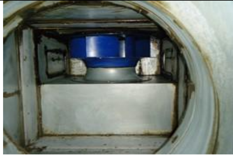
6. Fan Unit after
